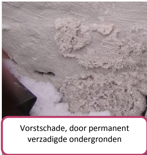
Opstijgend vocht, kaleien wordt niet aangezogen en kan resulteren in vorstschade
