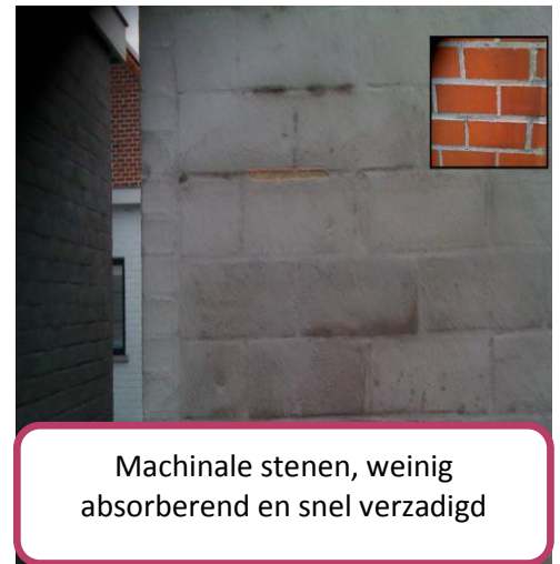
Beschadigde ondergrond, niet homogeen en onvoldoende stabiel
