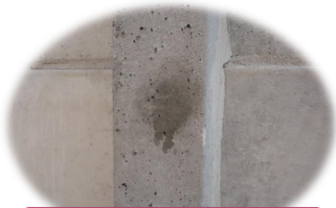
BETONNEN PAAL : Zuigende ondergrond
