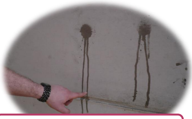
BETONNEN PLAAT : Niet zuigende ondergrond, want het water loopt af zonder te absorberen
