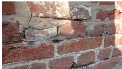
Loszittende voegen dienen hersteld te worden.
